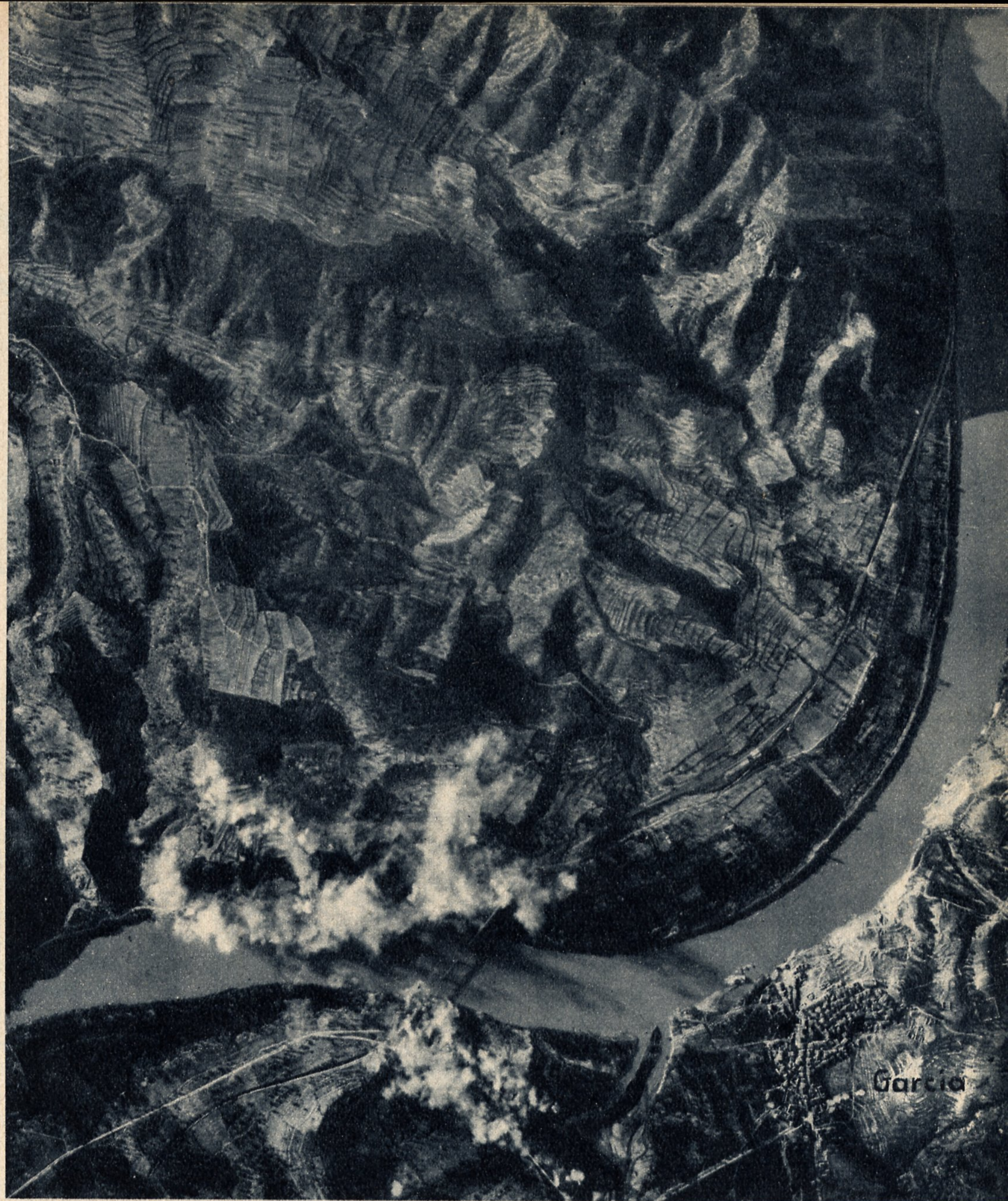
Von größter Wichtigkeit waren in dem an Verkehrswegen armen Lande die wenigen Eisenbahnbrücken über die großen Flüsse. Es mußte das Ziel der nationalen Heeresleitung sein, die Verbindungsmöglichkeiten im Roten Hinterland im weitestem Umfang zu stören. In unserem Bild sehen wir die Ebro-Brücke bei Garcia, die unter dem gezielten Bombenfeuer eines Kampfverbandes der Legion Condor liegt
