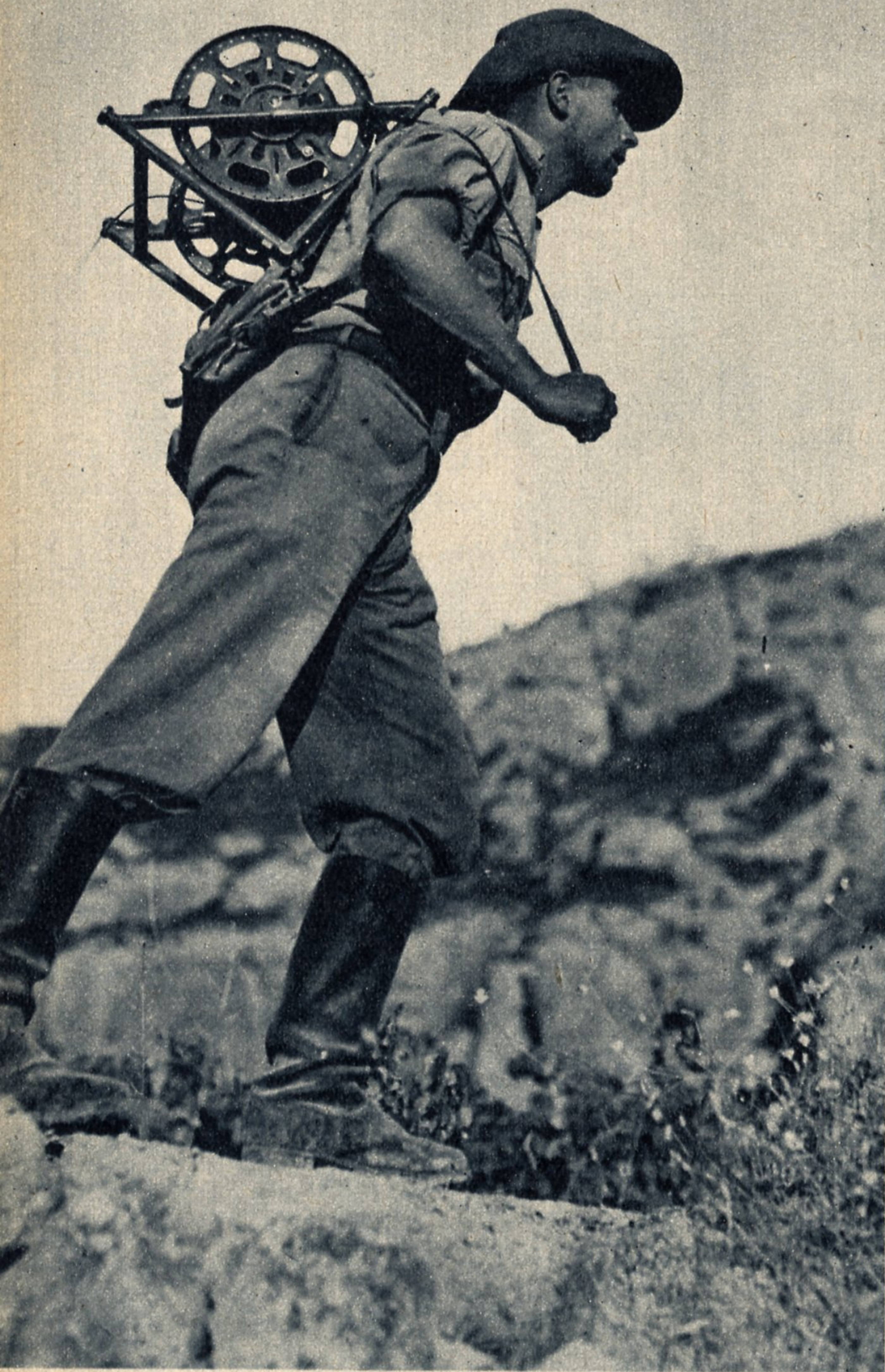
Der Gefechtsstand der Legion ist verlegt worden. Hierzu muß die Luftnachrichtentruppe mit größter Schnelligkeit alle erforderlichen Nachrichtenverbindungen herstellen. Hier sehen wir einen Mann mit der schweren Kabeltrommel bei dieser Arbeit
